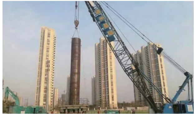
图 5.1 一体化施工平台护筒
