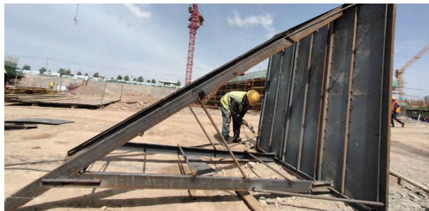
图 5.2.4 电梯井施工简易平台的加工制作照片
