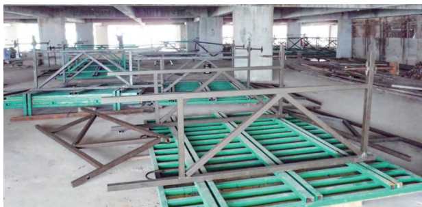
图 5.2.3-1 装配式大模板加工制作
