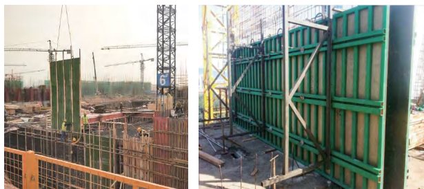
图 5.2.3-2 装配式模板吊运安装
