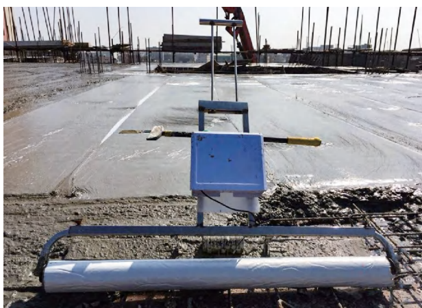
图 5.5.3 无线式混凝土振平覆膜一体机现场使用
