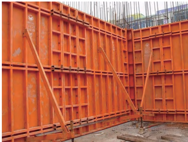
图 5.2.3-3 装配式大模板安装
