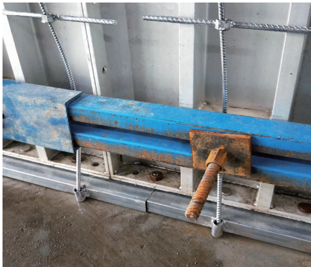
图 5.4.6-1 防止现浇混凝土剪力墙烂根的装置的现场应用
