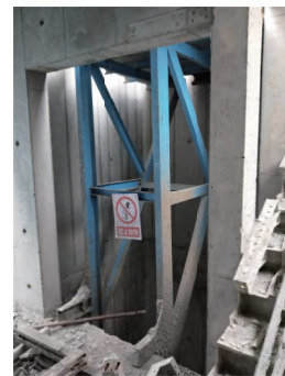
图 5.2.4 电梯井施工简易平台的加工制作照片
